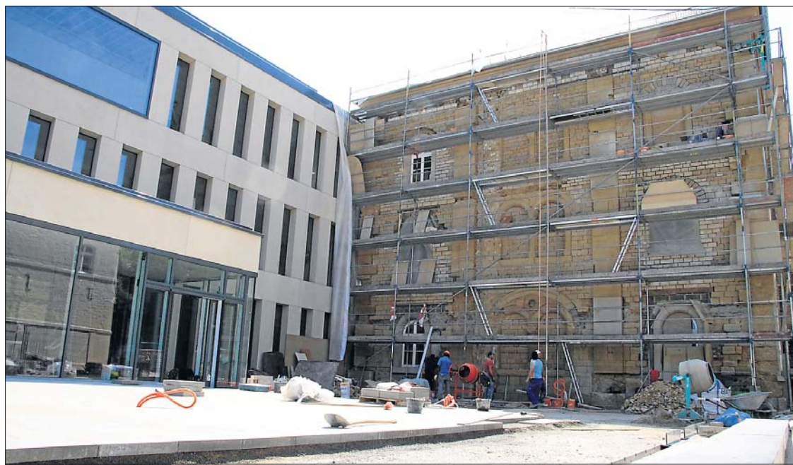
Bei den Renovierungsarbeiten wurden alt und neu miteinander verbunden.
